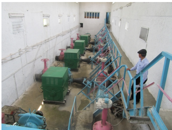
Рисунок 7: насосная станция реабилитацию (2015 г.)
